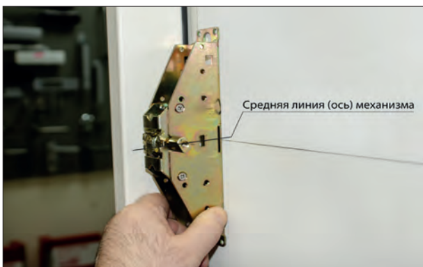
12. Приложить к дверному полотну спетлевой стороны приводной механизм в соответствии с нанесенной разметкой. Закрепить его на дверном полотне саморезами №1 (4 шт.).
