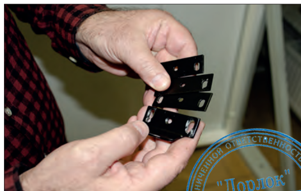
18. Установить ответную планку приводного механизма. Количество прокладок по-необходимости. Закрепить саморезами №7 (2 шт.) через крайние отверстия. Отрегулировать. Зафиксировать через центральное отверстие саморезом №7 (1 шт.).
