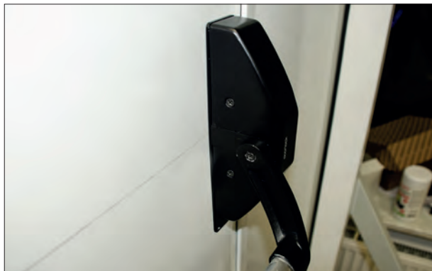
19. Установить кожухи на механизмы. Использовать винт № 4 (4 шт.).
