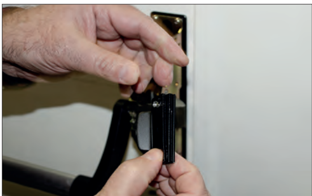
18. Установить ответную планку приводного механизма. Количество прокладок по-необходимости. Закрепить саморезами №7 (2 шт.) через крайние отверстия. Отрегулировать. Зафиксировать через центральное отверстие саморезом №7 (1 шт.).
