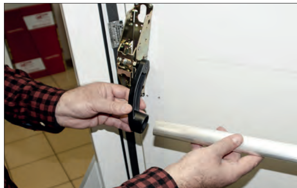
17. Вывернуть саморезы №1 (3 шт.) крепления механизма с петлевой стороны за исключением верхнего правого (в нашем случае). Отвести механизм в сторону для упрощения монтажа балки в нажимные рычаги. Снова закрепить механизм на полотне двери саморезами №1 (3 шт.).
