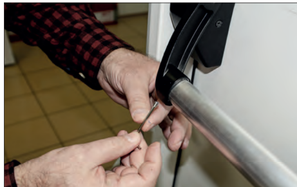
20. Зафиксировать балку в нажимных рычагах. Использовать шестигранный ключ.
