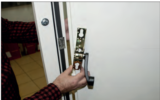
17. Вывернуть саморезы №1 (3 шт.) крепления механизма с петлевой стороны за исключением верхнего правого (в нашем случае). Отвести механизм в сторону для упрощения монтажа балки в нажимные рычаги. Снова закрепить механизм на полотне двери саморезами №1 (3 шт.).
